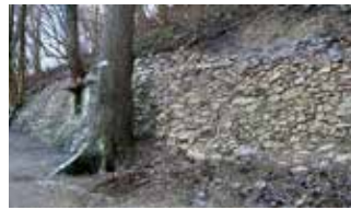
Občina Škofja Loka, barbara.pokorn@skofjaloka.si, www.skofjaloka.si; Zavod 973
